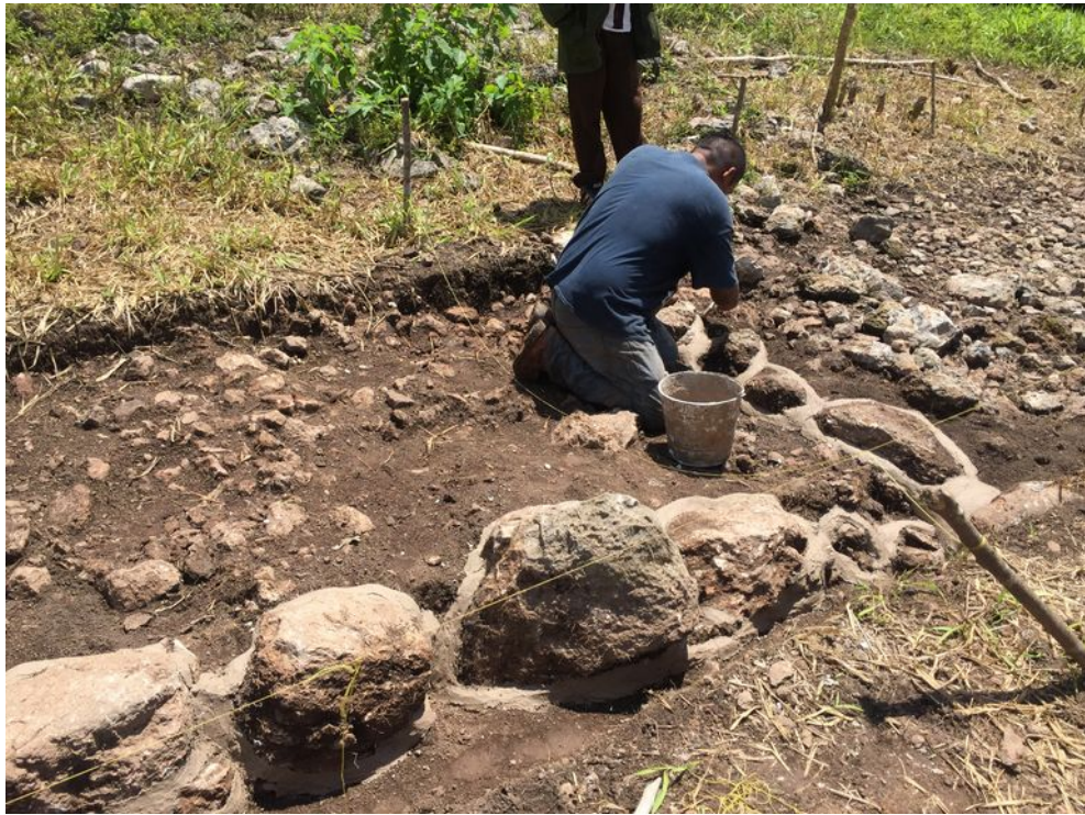
Figura 159. San Felipe, Operación 14, Elementos 1 y 2 consolidados
